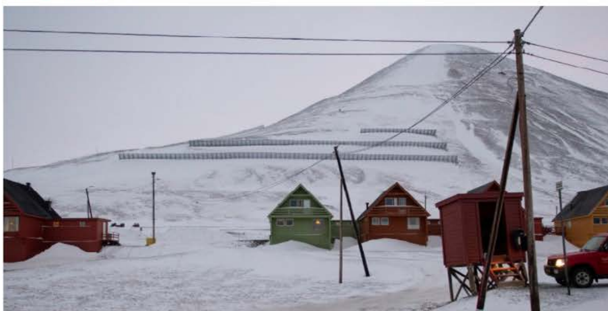
SIKRES: Området nedenfor spisshusene som ble tatt av skredet i 2015 blir sikret slik at det er mulig å bygge der. FOTO: LINE NAGELL YLVIÅKER
