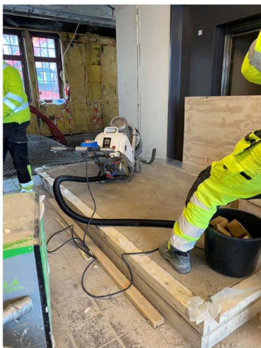
Oppstart sliping av prøve etter 4 uker herding
