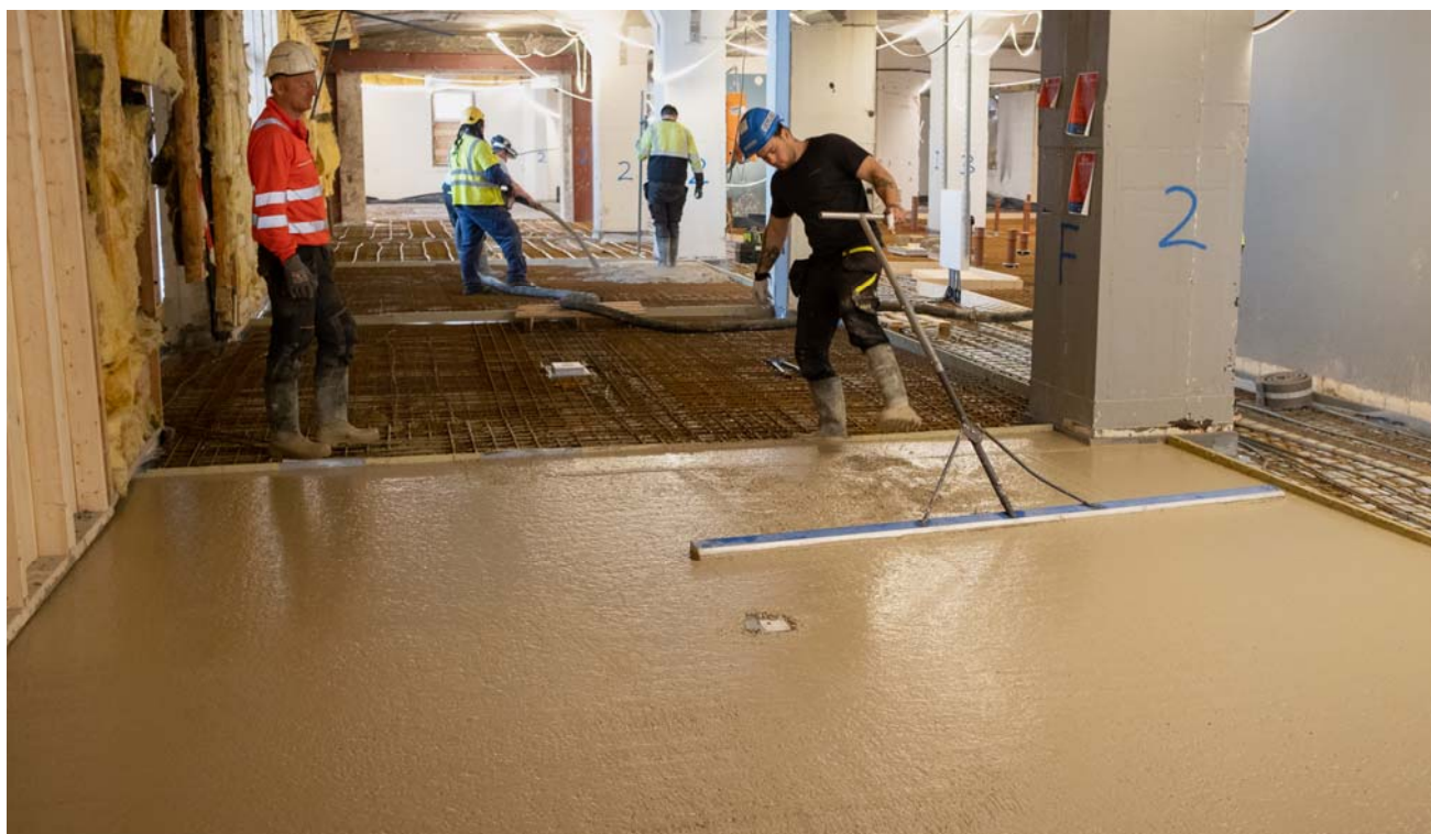
Uttøpning av første støpetappe mai 2021
