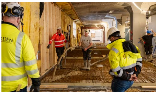
Utsøping av første støpetappe mai 2021
