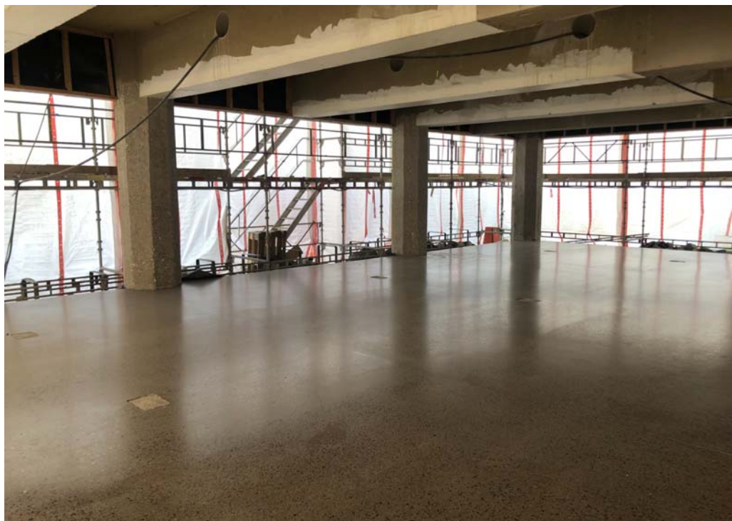
Ferdig slipt betonggulv behandlet med første toppbehandlingsstøk juli 2021
