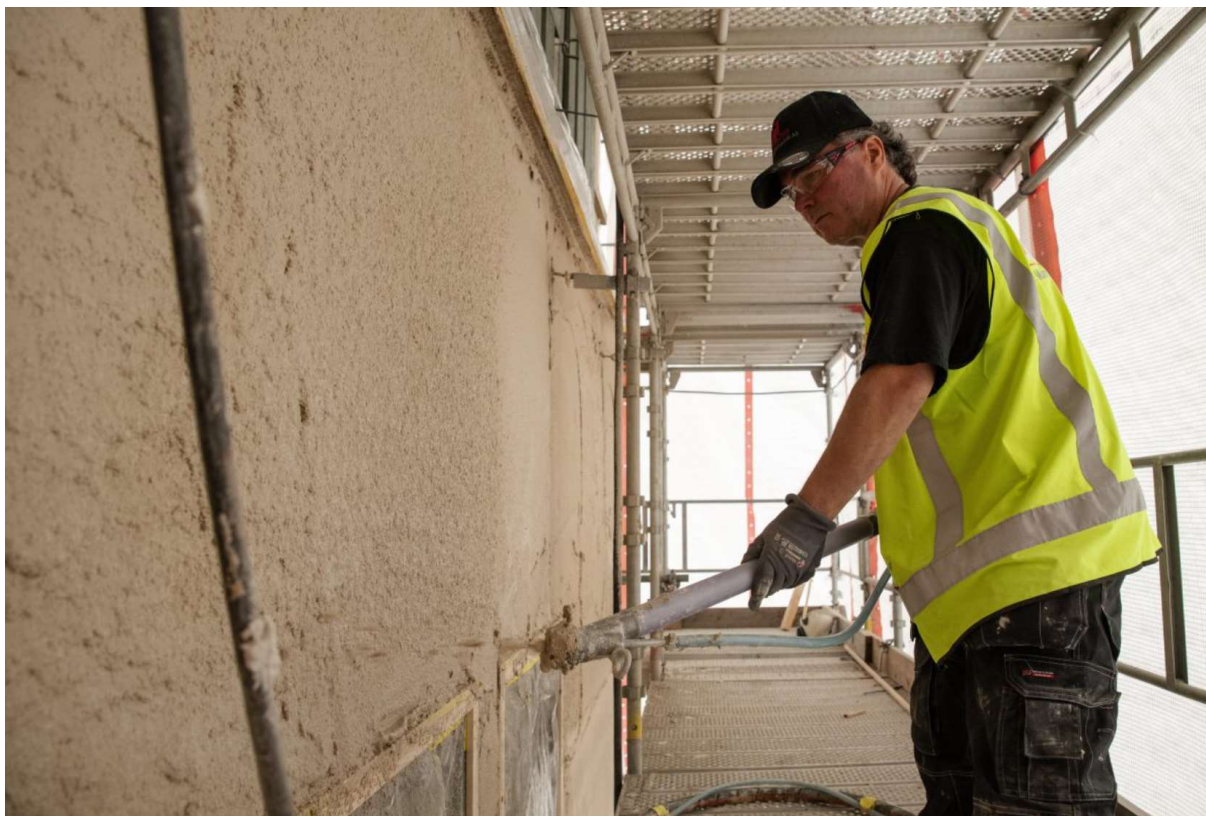
Påføring av Isokalk, Oslo Murmesterbedrift AS
