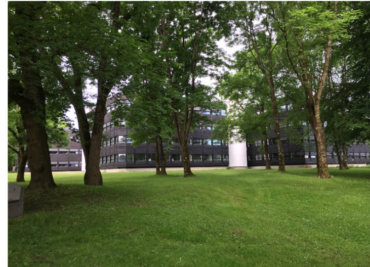
Blokk 3, 4 og 5 etter rehabilitering
