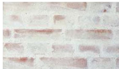
All tegl blir til slutt filset for å få et helhetlig uttrykk
