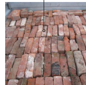
Gulv: -Tegl fra Urtegata via Resirql/Skanska -Balkongbygg
