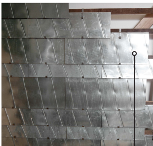
Taktekking: -resirkulerte ventilasjonskanaler i stål. -evt noe kanalplast 1x1m fra Motekbygget øverst.
