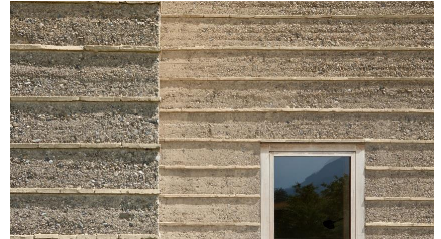
Quelle: Haus Rauch, Schlins (© Beat Bühler, Martin Rauch)
