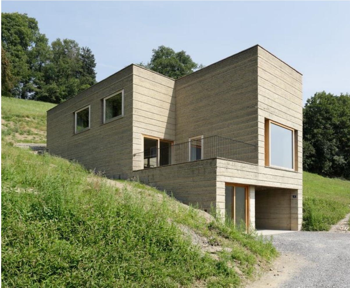
Quelle: Haus Rauch, Schlins (© Beat Bühler, Martin Rauch)
