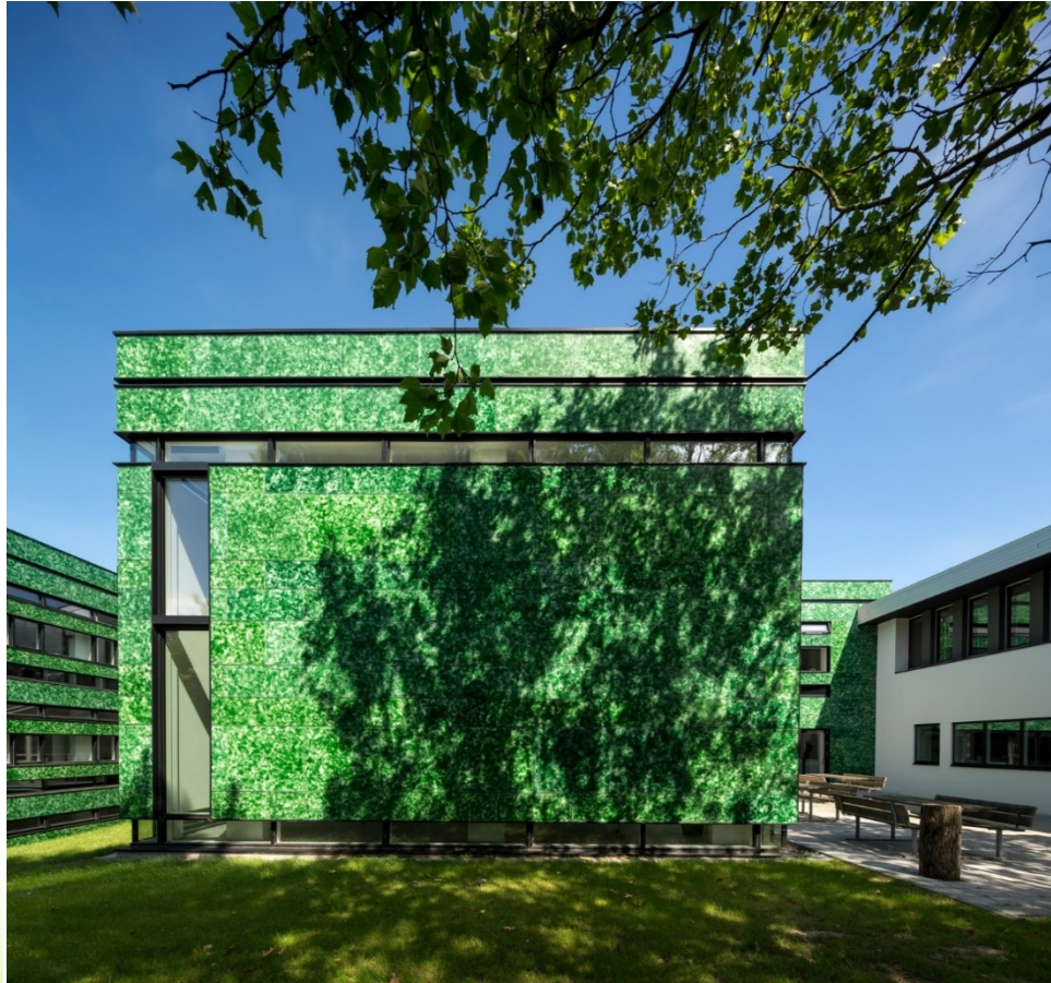
Kontorbygning for Århus Kommune Grøndalsvej i Århus. Foto SHL Arkitekter
