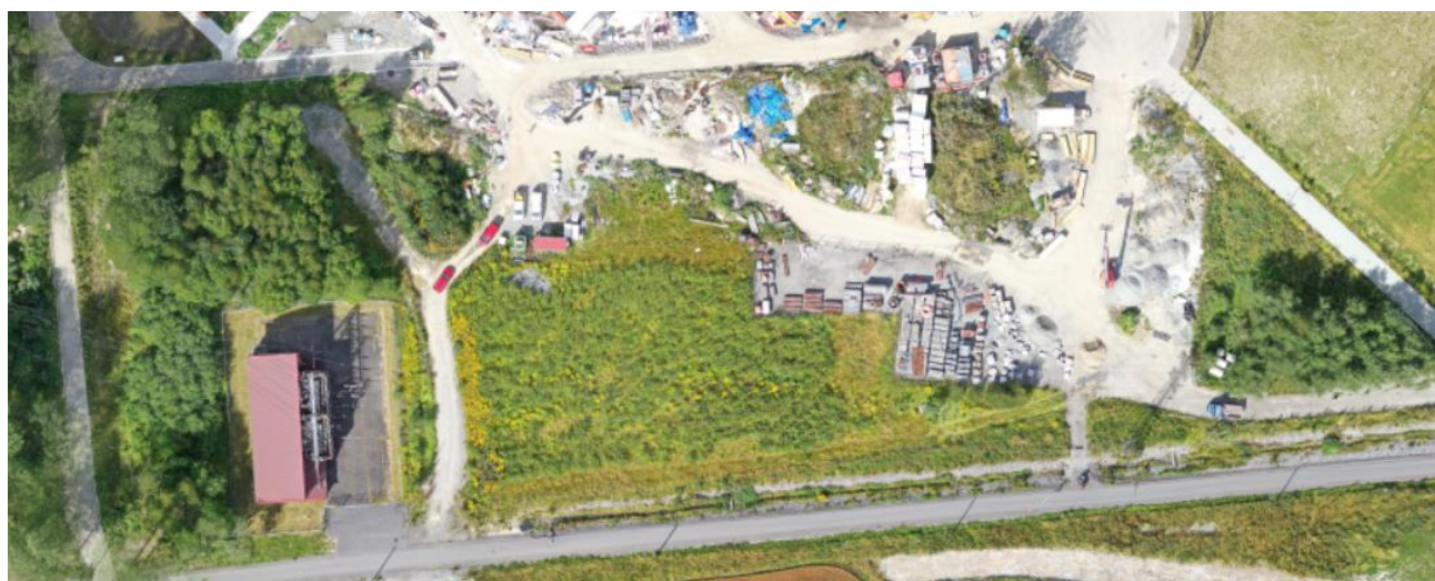
Figur 1. Eksisterende areal før oppstart byggearbeider.
